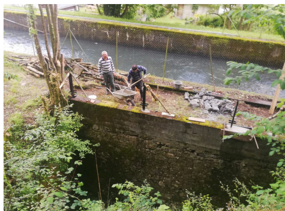
Travaux fosse rocher école. Crédit photo : S. Marmer
